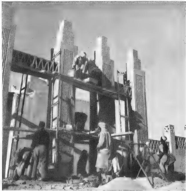
Un chantier au travail.
